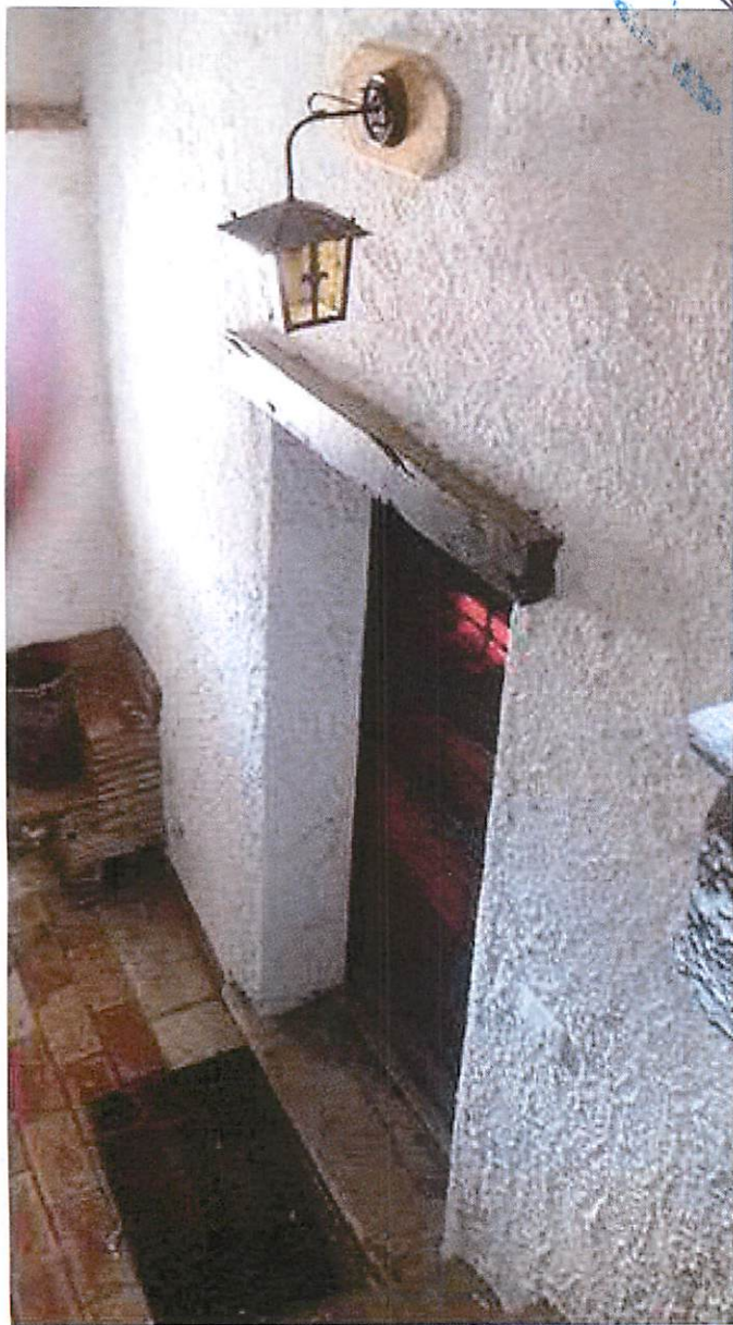
FOTO 1 (ingresso piano seminterrato)
